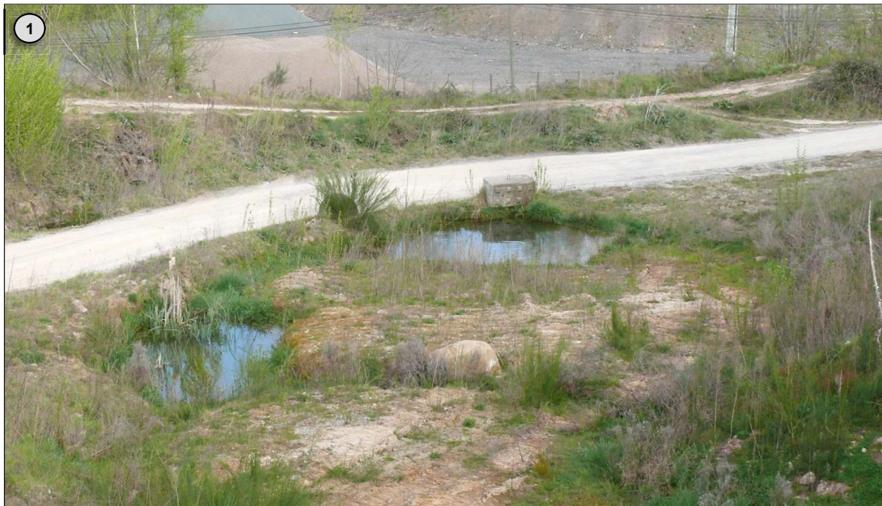
1. Vue sur les deux bassins de décantation situés à l'extrémité nord de la carrière (habitat 3). Avril 2021.
